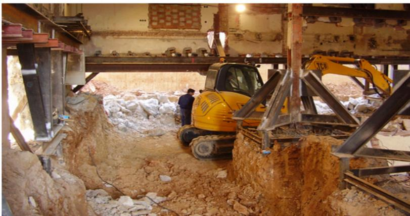
22 Trabajos de recimentación y excavación de un nuevo sótano
